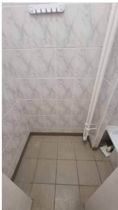
Zdjęcie nr 26: POMIESZCZENIA HIGIENICZNO-SANITARNE - przedsionek do natrysku
