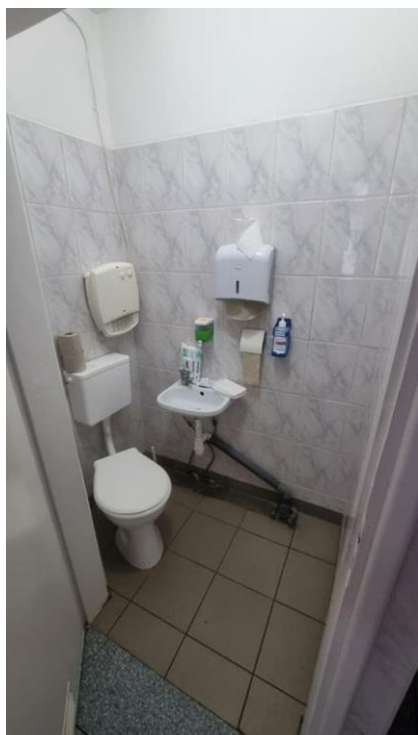
Zdjęcie nr 28: POMIESZCZENIA HIGIENICZNO-SANITARNE – toaleta przy sali dla pacjentów
