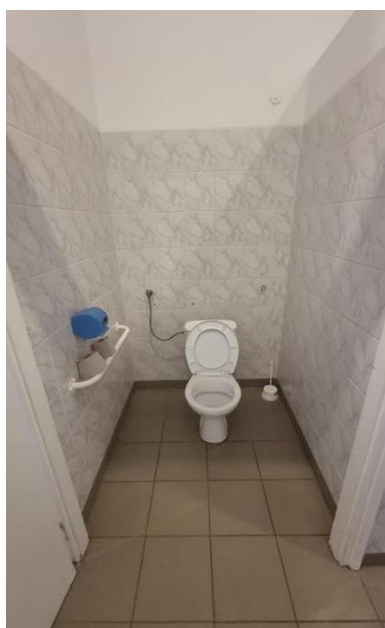
Zdjęcie nr 25: POMIESZCZENIA HIGIENICZNO-SANITARNE – toaleta
