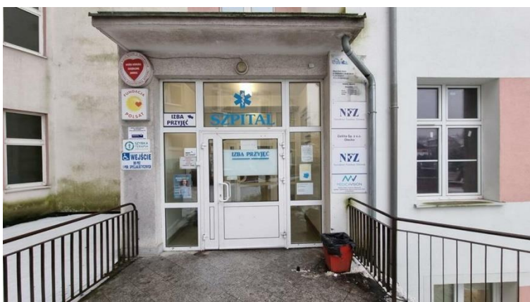
Zdjęcie nr 10: WEJŚCIE - główne
