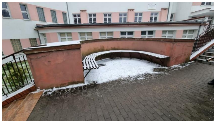
Zdjęcie nr 5: Dojście - rejestracja pacjentów miejsce odpoczynku
